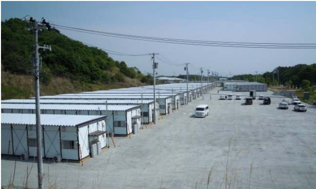
福島県相馬市の仮設住宅135戸の竣工時写真(横浜支店 山田課長施工)
