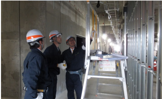
帯広(22)連隊庁舎の現場巡視
