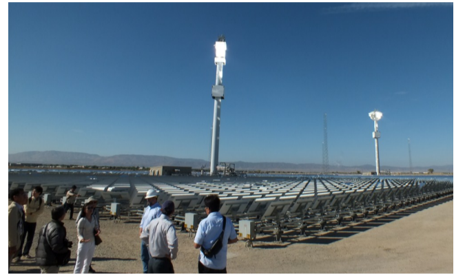
広大な土地にある太陽光発電所
