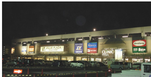
上尾愛宕ショッピングセンター新築工事 不二建設株式会社 埼玉県
