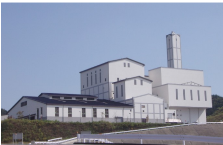
エコフロンティアかさま溶融処理施設建設工事 戸田建設株式会社 茨城県
