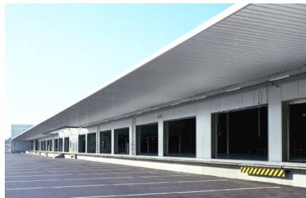
東京インテリア家具鹿沼物流センター新築工事 鹿島建設株式会社 栃木県
