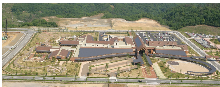
総合リハビリテーションセンターブランチリハビリ専門病院電気設備工事 兵庫県
