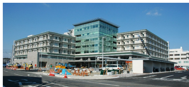
平成14年度榛原総合病院増改築事業電気設備工事 榛原総合病院組合 静岡県
