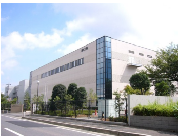
新藤電子工業沼南工場東サイロ新棟建設工事 新藤電子工業株式会社 千葉県
