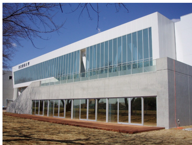
東京理科大学(仮称)カナル会館新築工事 株式会社竹中工務店 千葉県
