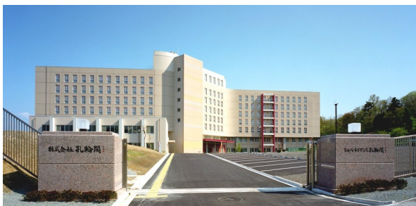
(仮称)有料老人ホームシルバーレジデンス孔輪閣新築工事 安藤建設株式会社 福島県
