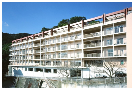
熱海伊豆海の郷新築工事(第2期) 株式会社フジタ 静岡県
