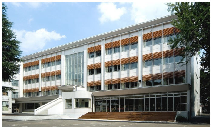
成蹊中学HR棟新築工事の内電気設備工事 大成建設株式会社 東京都
