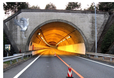
山陽自動車道竜ヶ岳トンネル照明設備取替工事 西日本高速道路株式会社 山口県
