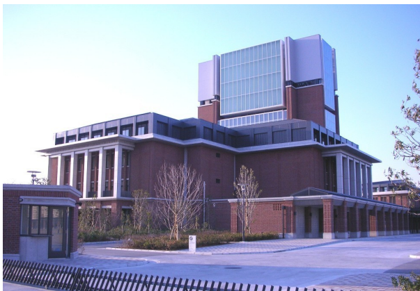
神戸学院大学ポートアイランドキャンパス建設工事(電気設備工事)A棟 株式会社竹中工務店 兵庫県
