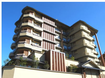
白玉の湯華鳳「別邸越の里」増築工事 株式会社福田組 新潟県
