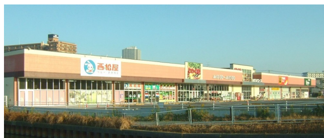
(仮称)いばらきコープ土浦小松店新築工事 常総開発工業株式会社 茨城県
