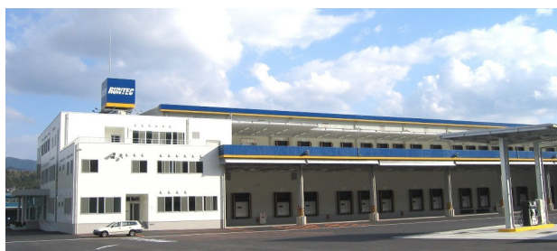
(仮称)ランテック福岡支店新築電気設備工事 株式会社NIPPOコーポレーション 福岡県
