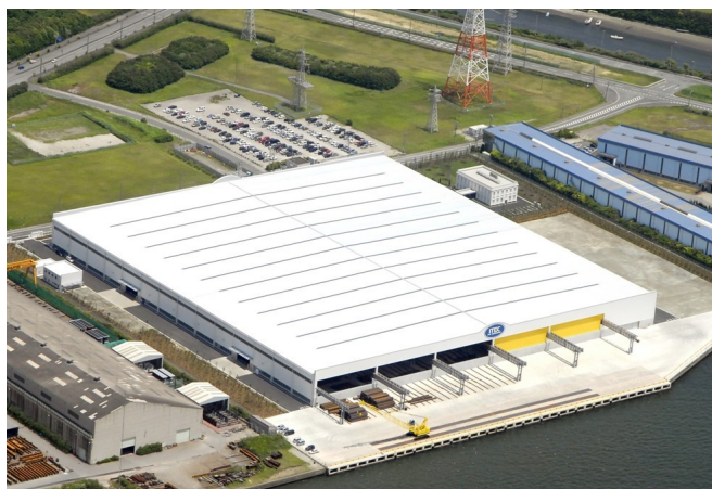
(株)アイ・テック東京工場工場棟(A工区)新築工事 株式会社大林組 千葉県
