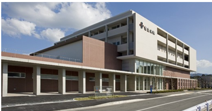
恒生病院新築電気設備工事 株式会社大林組 兵庫県
