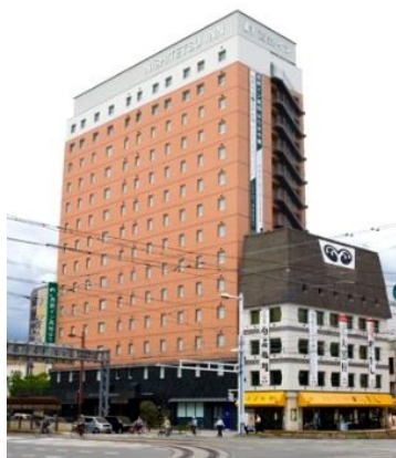
(仮称)はりまや橋ニューコウチビル 新築電気設備工事 大成建設株式会社 高知県
