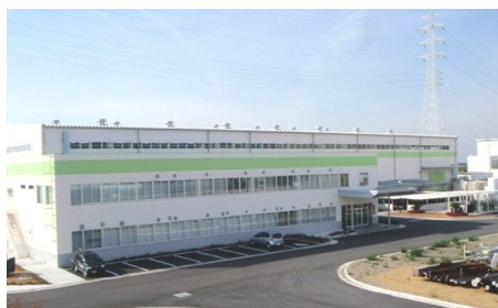
三菱高砂大冷部新工場電気設備工事 三菱重工業株式会社 兵庫県
