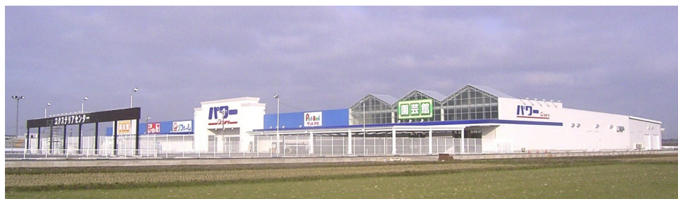
コムリパワー新発田店新築工事 新発田建設株式会社 新潟県
