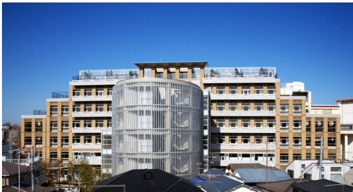
拓殖大学文京キャンパス整備事業第1ステージ中央教室棟・南教室棟 建築物 西松建設株式会社 東京都
