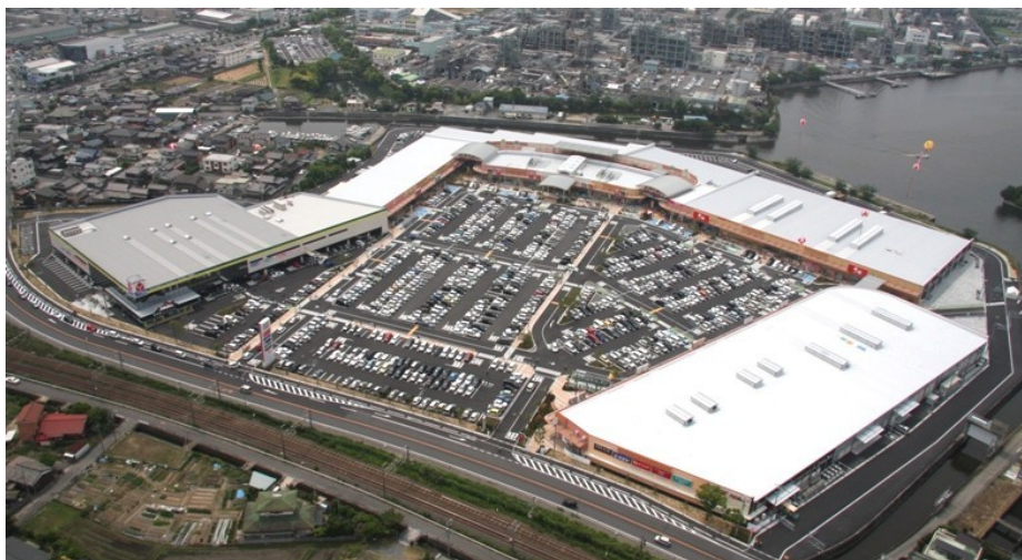
ロックタウン周南新築工事 大和ハウス工業株式会社 山口県
