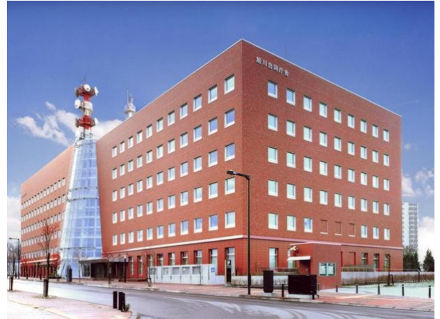
旭川合同(Ⅱ期)電気設備(電力)工事 国土交通省北海道開発局 北海道
