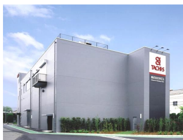
(株)タチエス青梅工場新衝突実験棟 新築工事 前田建設工業株式会社 東京都
