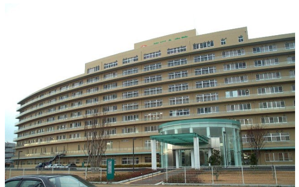
医療法人徳洲会(仮称)大垣徳洲会病院新築工事 株式会社大林組 岐阜県
