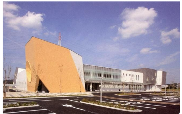
(仮称)日進市立図書館新築工事 株式会社フジタ 愛知県
