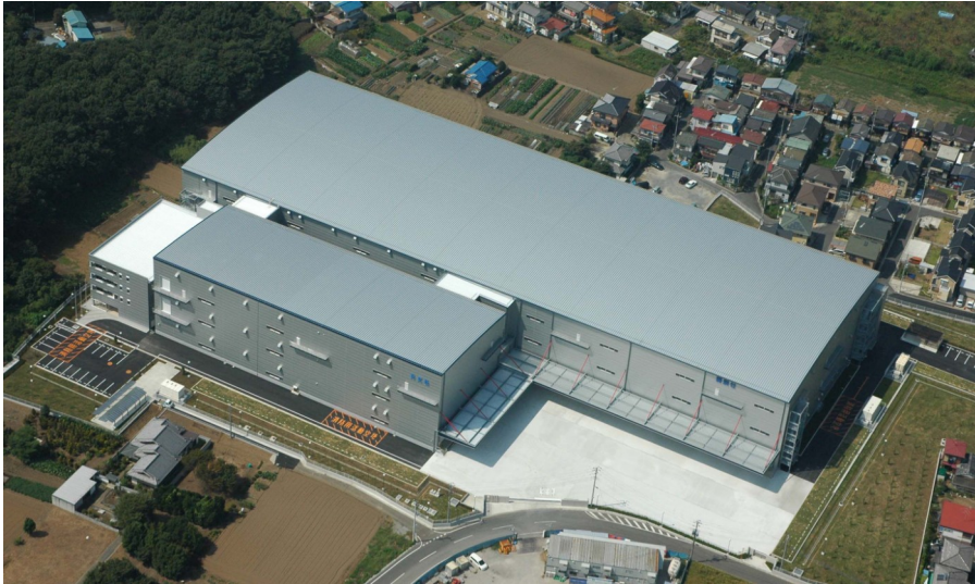
講談社桶川流通センタープロジェクト新築工事 株式会社フジタ 埼玉県
