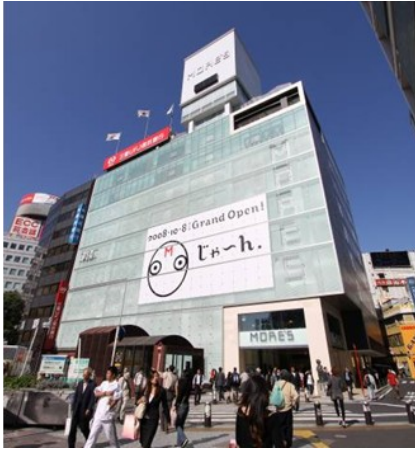
横浜岡田屋モアーズリニューアル工事 大成建設株式会社 神奈川県
