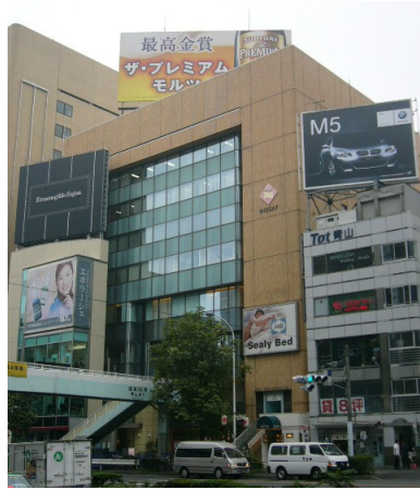
青山サンクレストビル共用設備改修工事 戸田建設株式会社 東京都
