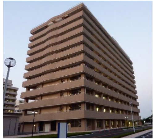
徳島大学(医・歯病)西病棟新営その他電気工事 国立大学法人徳島大学 徳島県
