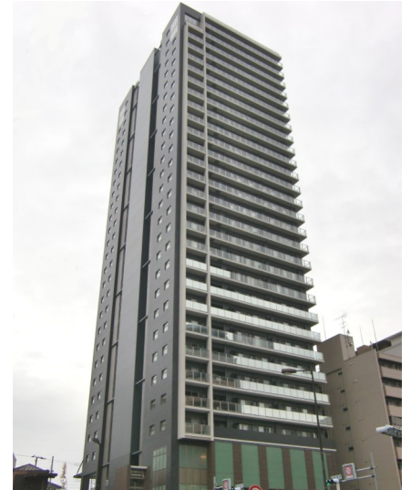
(仮称)松屋タワー新築工事 前田建設工業株式会社 大阪府
