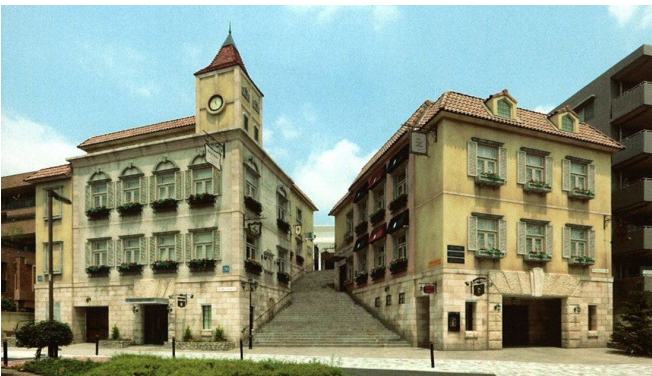
(仮称)TAKAMIブライダルNAGOYA新築工事 大成建設株式会社 愛知県
