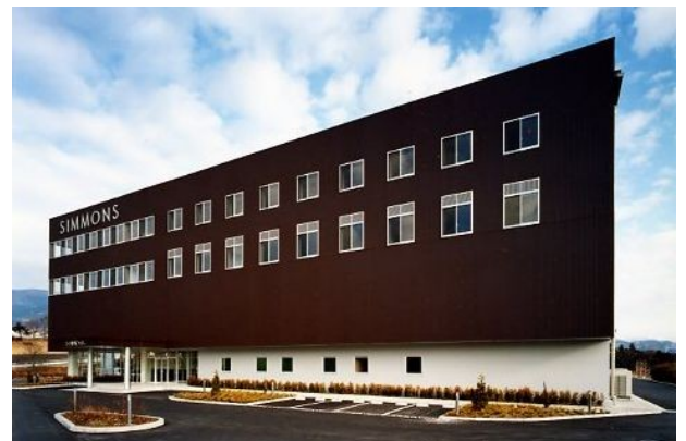
(仮称)シモンズ富士小山工場新築電気設備工事 矢作建設工業株式会社 静岡県
