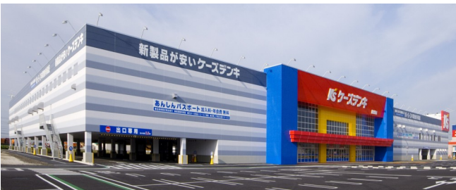
(仮称)ケースデンキ仙台東店新築工事 株式会社大林組 宮城県
