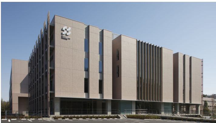
昭和薬科大学第2講義棟新築工事 飛鳥建設株式会社 東京都
