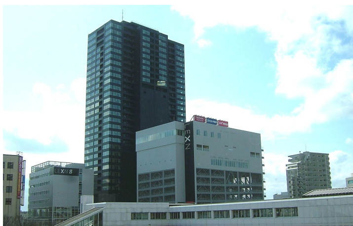
LEXN(新潟駅南口市街地再開発) 清水建設株式会社 新潟県
