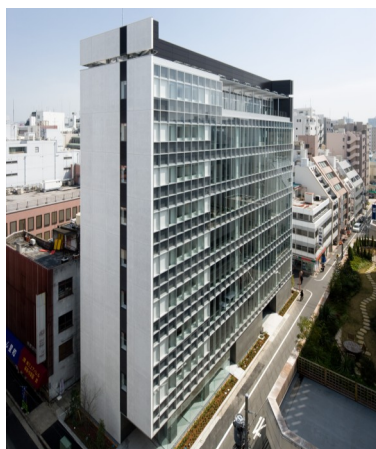
ユアサ商事株式会社 本社ビル別館 株式会社銭高組 東京都
