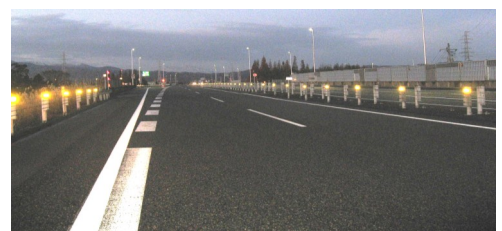
北陸自動車道 親不知～柿崎間道路照明設備 東日本高速道路株式会社 新潟県
