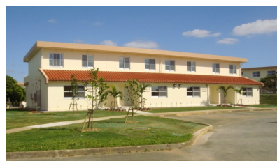
米軍家族住宅PHASE6改修 西松建設株式会社 沖縄県
