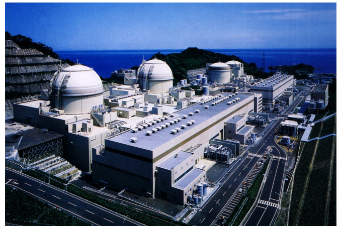
関電電力大飯各発電所定検 関電プラント株式会社 福井県
