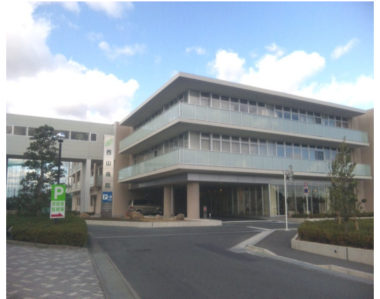
西山病院本館 大成建設株式会社 静岡県
