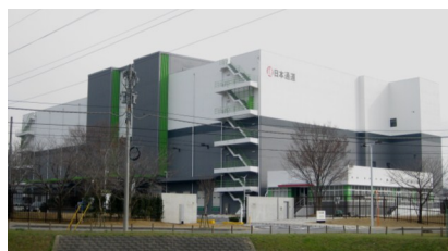
グッドマン守谷2号棟 株式会社間組 茨城県
