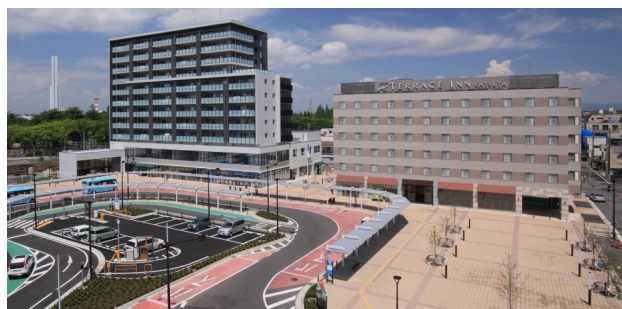
アネージュ勝田シティフォート(住宅棟)／テラスイン勝田 株式会社熊谷組 茨城県
