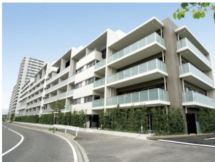
渚ガーデン／タワーヴィレッジ8番館 西松建設株式会社 広島県
