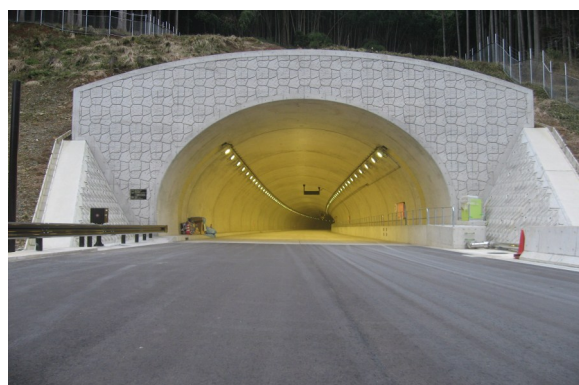
和田山八鹿道路畑トンネル外照明設備設置 国土交通省近畿地方整備局 兵庫県
