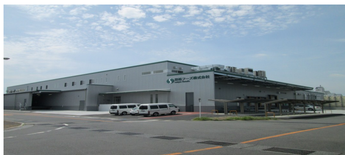
マミーマート川越生鮮センター 前田建設工業株式会社 埼玉県
