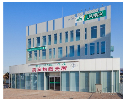
JA横浜都筑中川 日本国土開発株式会社 神奈川県
