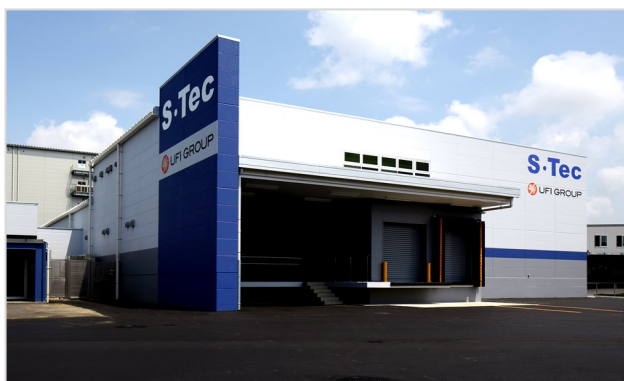
(仮称)S・Tecフーズ(株)つくばファクトリー2期新築工事 株式会社熊谷組 茨城県
