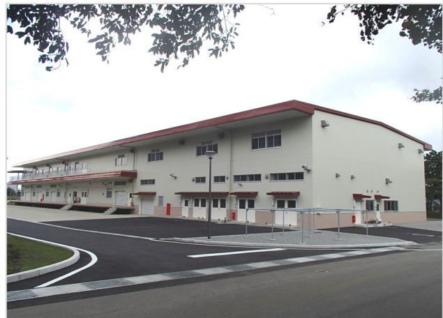
相模米軍(H24)野積場(0017)新設電気その他工事 南関東防衛局 神奈川県
