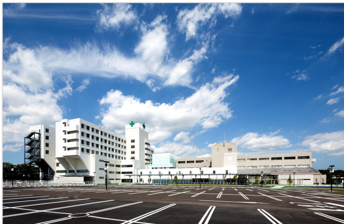
千葉労災病院新棟電気設備工事 独立行政法人労働者健康福祉機構 千葉県
