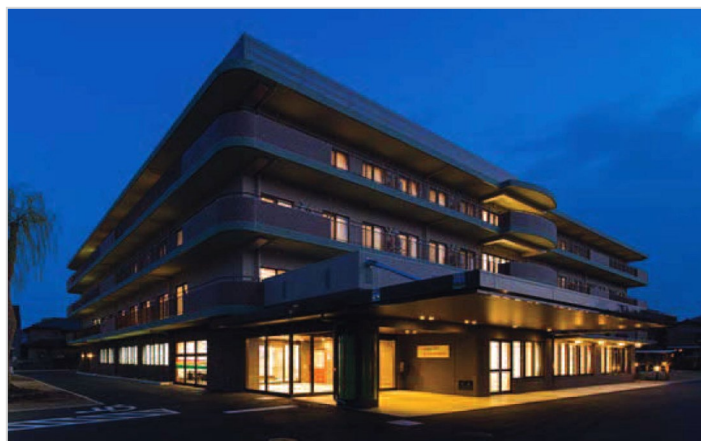
特別養護老人ホーム こもれびの丘新築工事 前田建設工業株式会社 埼玉県
