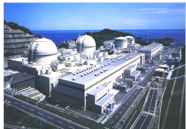
関西電力大飯発電所原子力定検 関電プラント株式会社 福井県
