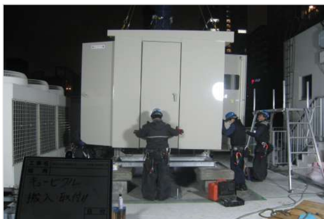
キュービクル更新工事
