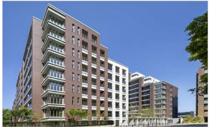
藤崎公団住宅マンション建替え計画新築工事(電気設備) 西松建設株式会社 福岡県
