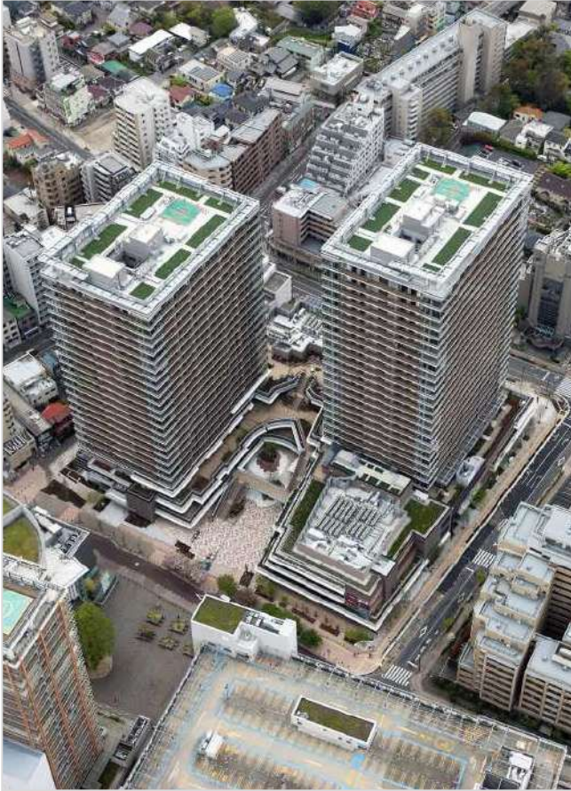
武蔵小金井駅南口第2地区市街地再開発事業(A棟B棟住宅部電気) 清水建設株式会社 東京都
