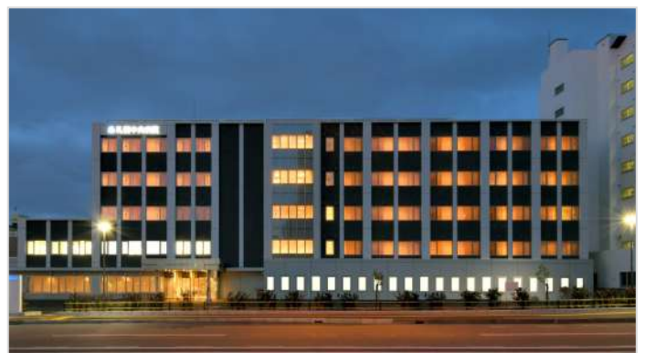
札幌中央病院改築工事 戸田建設株式会社 北海道
