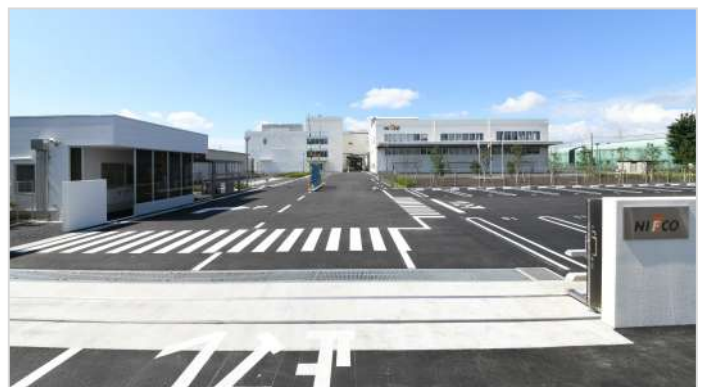
株式会社ニフコ相模原エンジニアリングセンター増改築工事 矢作建設工業株式会社 神奈川県
