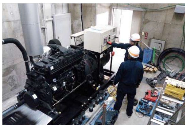
非常用発電設備更新工事 試運転状況
