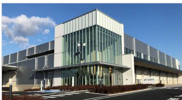
(仮称)バルシステム熊谷センター新築工事 日本国土開発株式会社 埼玉県
