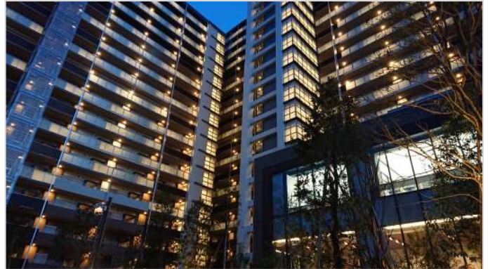
(仮称)日吉箕輪町計画 A工区 三井住友建設株式会社 神奈川県
