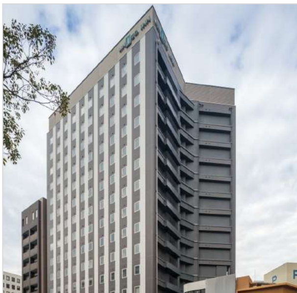
(仮称)京橋PJ新築工事及び客室フロア内装仕上げ工事 株式会社奥村組 広島県
