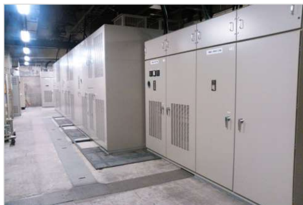
特高受変電設備更新 工事
