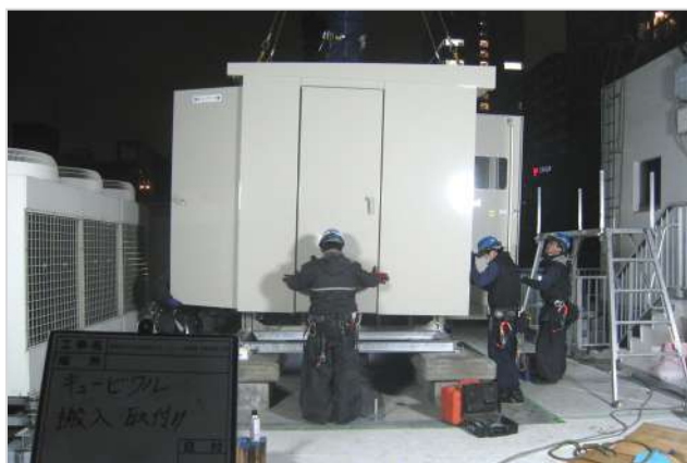
キュービクル更新工事
