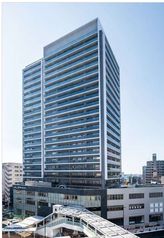
本厚木駅南口地区第一種市街地再開発事業施設建築物建築工事 株式会社フジタ 神奈川県
