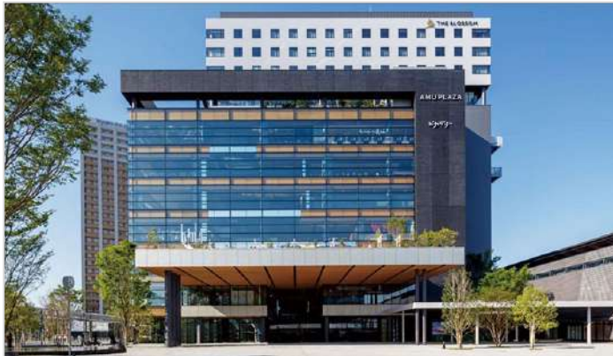
熊本駅ビル(仮称) 新築工事(ホテル電気設備) 株式会社大林組 熊本県
