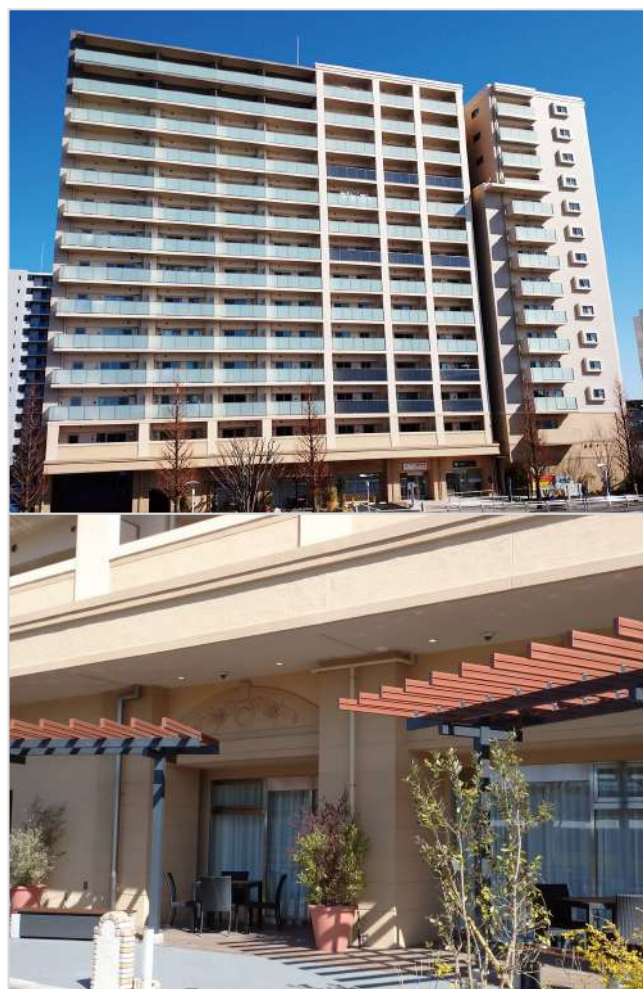
(仮称)ひたち野うしく駅直結シニアPJ新築工事 飛島建設株式会社 茨城県
